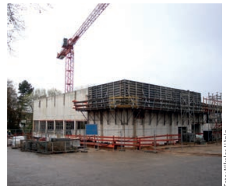
Baustelle zum neuen Bürgerhaus
